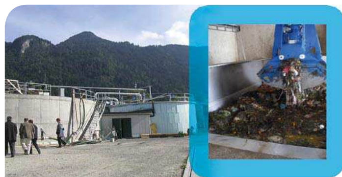
Figura 1 Unidade de digestão anaeróbica em cogeração para valorização de resíduos orgânicos da agricultura e indústria e de RU.
